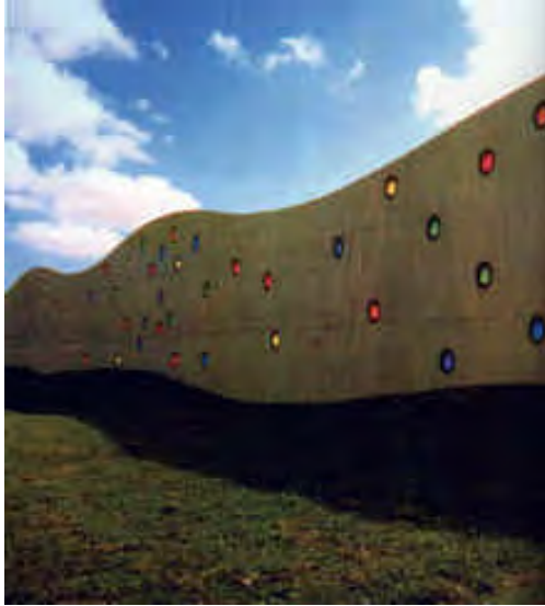
Foto: Muro de atenuación acústica, saca el máximo provecho de esta orientación en principio adversa, utilizando la luz del sol como principal elemento dinamizador del muro.
