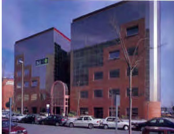
Foto en donde se enmarca el acceso
