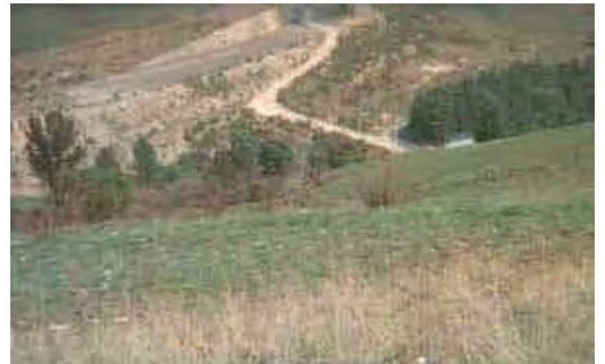
f) Fotografía con Vista Oeste hacia el camino en construcción a la Carr. Toluca-Qro.
