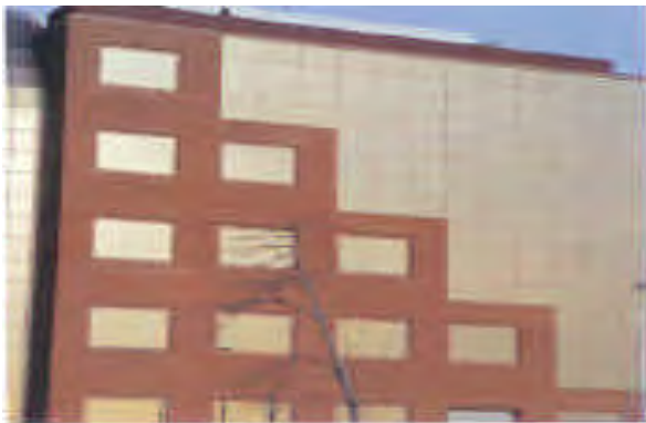
Foto del detalle de las fachadas
