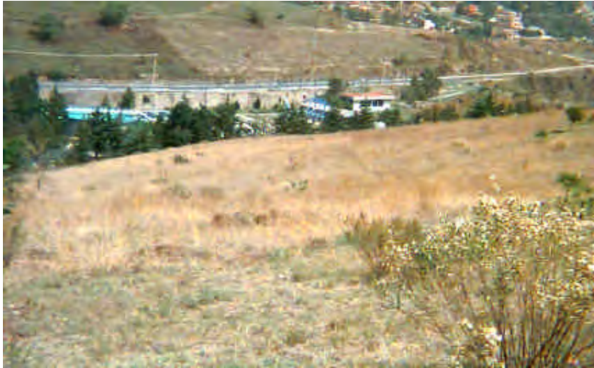
g) Fotografía con Vista Oeste hacia la Planta Potabilizadora de Atizapán
