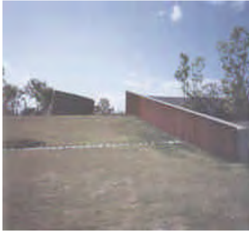
Foto: vista de los grandes muros que delimitan y dan un elemento escultórico.
