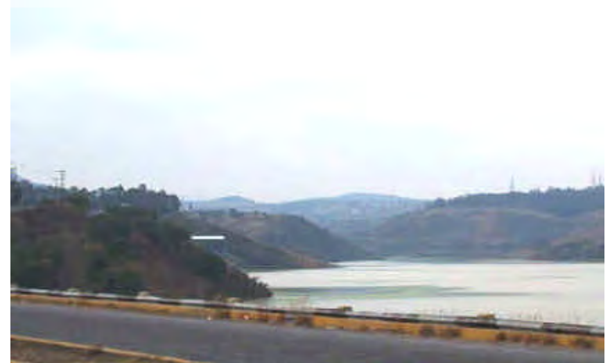
11) Fotografía con vista a la Presa Madín desde el dique.
