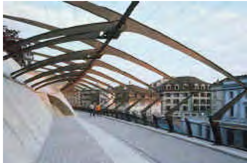
Foto de la estación de Stadelhofen
