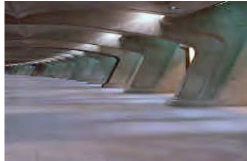
Foto de un espacio de la estación
