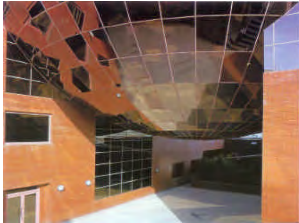
Foto de detalle de la intersección de la esfera con el edificio
