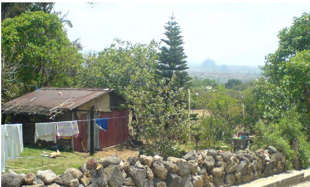
Fig. 24. Vivienda con muros y techo de lámina de cartón.
