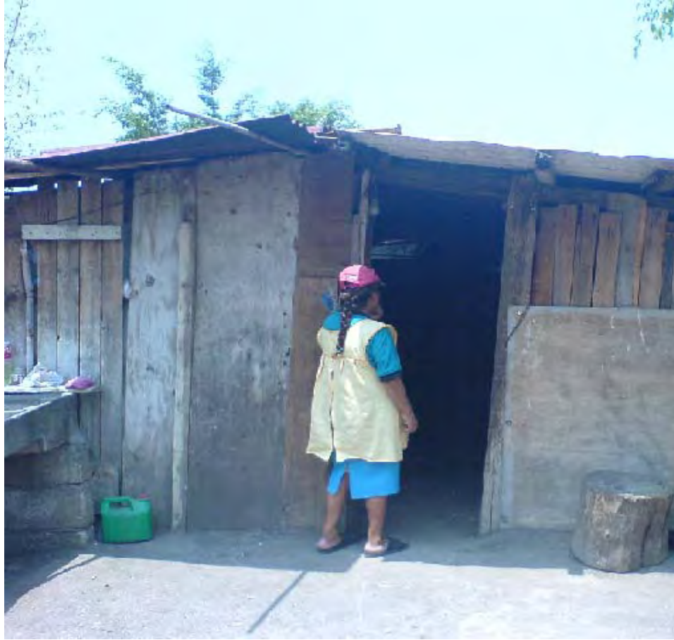
Fig. 25. Vivienda con muros de madera y techo de lámina de cartón.
