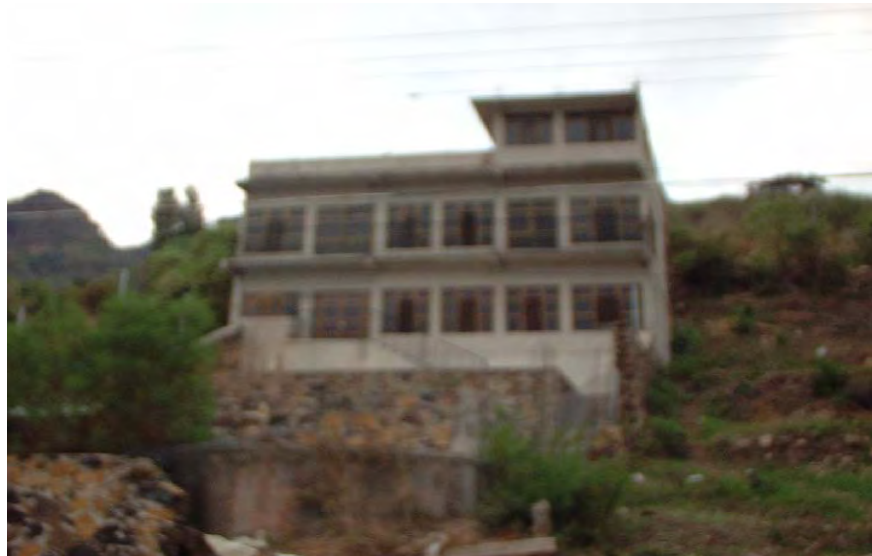
Fig. 26. Vivienda con muros aplanados y techo de cemento.
