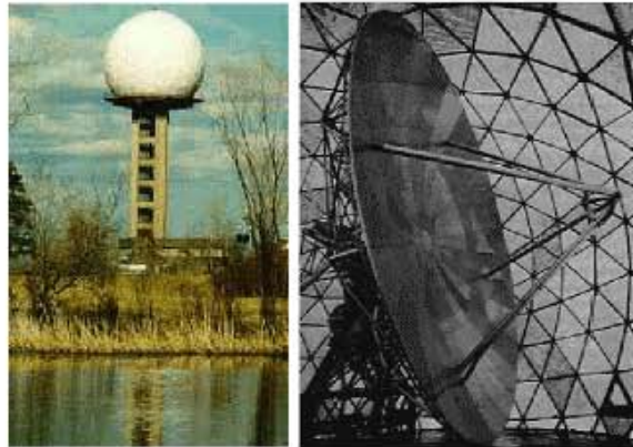
Radar de banda S del Marshall radar Observatory (MRO), en Montreal, Canadá, con un disco de unos 10 m de diámetro
