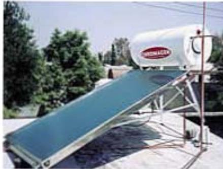
En particular, un equipo doméstico cuenta con un contenedor de entre 1.5 y 3 m<sup>3</sup> de capacidad; el recipiente está forrado con un aislamiento térmico en el interior, mientras que en la parte externa posee una cubierta que lo protege del medio ambiente. Comúnmente son de materiales porcelanizados, acero al carbón, plástico, fibra de vidrio o lámina galvanizada.
