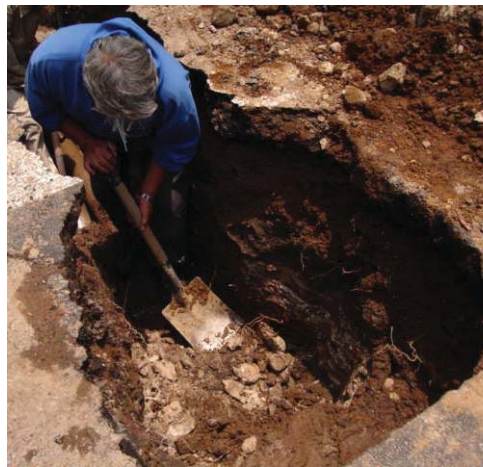
EJEMPLO EXCAVACIÓN EN VIA PÚBLICA
