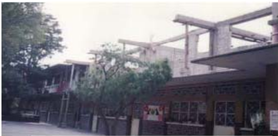
9. Construcción del primer piso del edificio A. 1992
