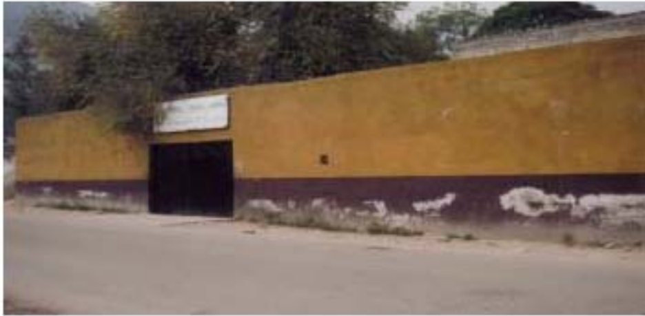
6. Fachada del Colegio en el año de 1975 (aproximadamente).
