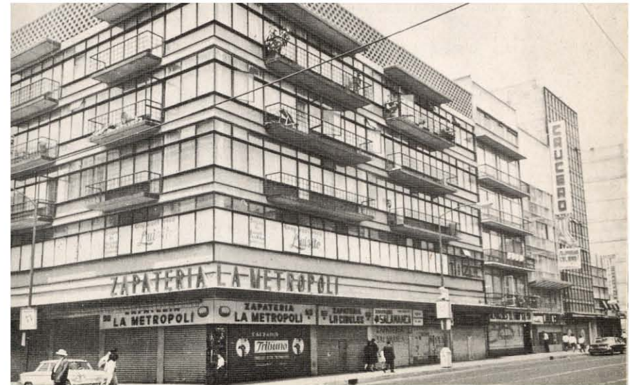
El mismo tramo hacia 1960
