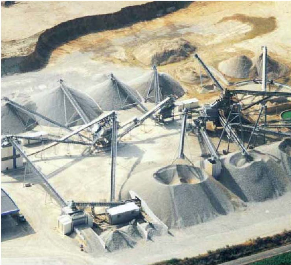
Fig. IV.8 Pilas de almacenaje en una planta de agregados.
