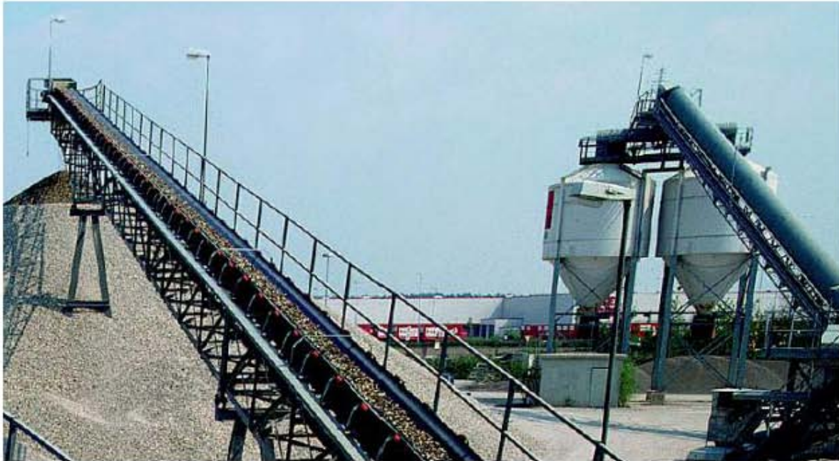
Fig. III. 31 Banda transportando agregado hacia una pila.
