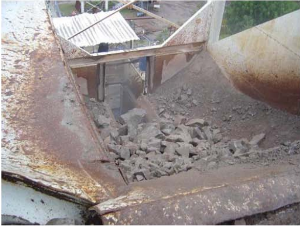
Fig. III.2 a) Tolva de recepción de material en la planta de agregados en Xometla, Edo. de México. La roca que se ve tiene un tamaño máximo de 42”.
