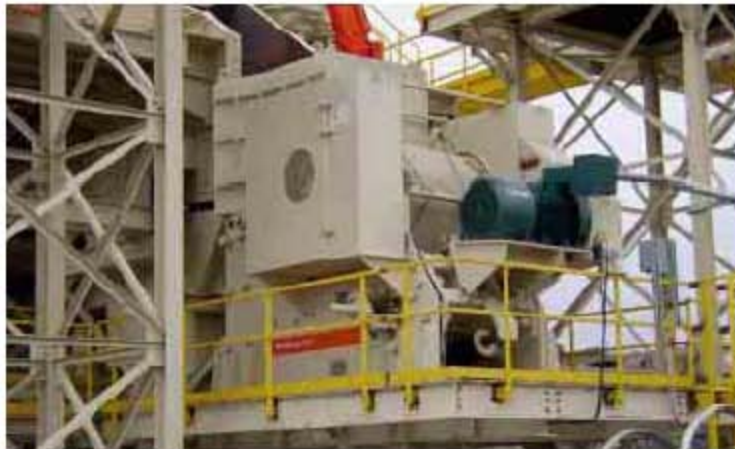
Una C125 durante la fase de instalación en una planta de trituración primaria.
