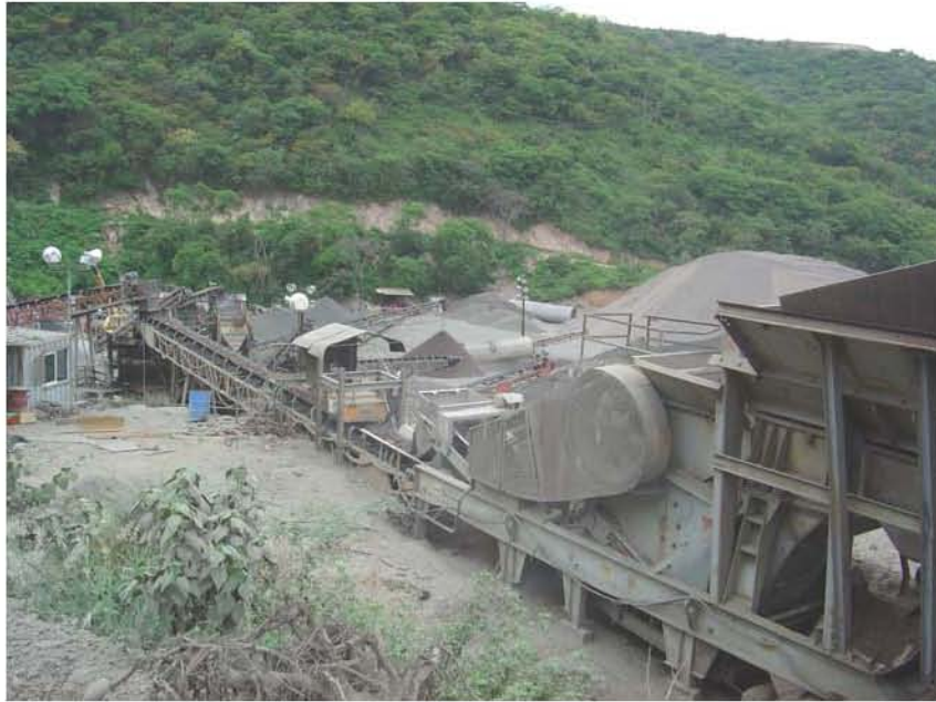
Fig. IV.10 Vista del equipo primario en una planta estacionaria. Se aprecia la tolva de recepción de material, la trituradora de quijadas, la banda transportadora y el imán sobre ésta. El material va a una criba para el proceso secundario.
