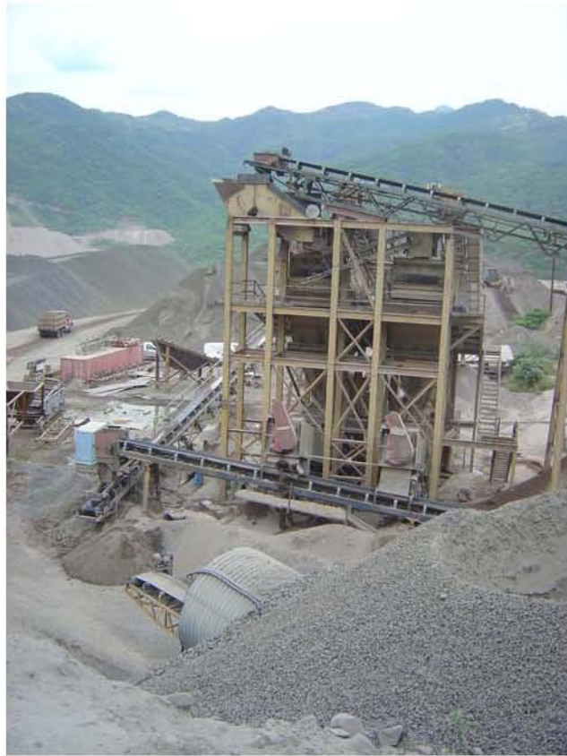
Fig. IV.14 Otra vista del equipo de cribado terciario.
