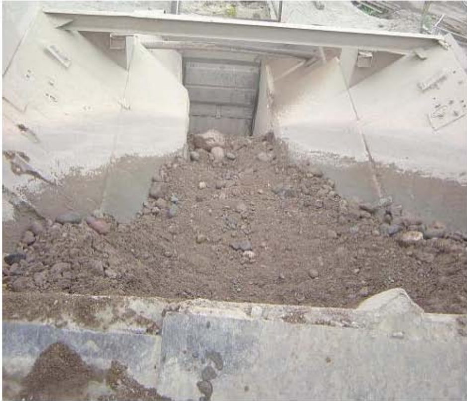
Fig. III.2 b). Tolva de recepción en planta de producción de agregados. Se aprecia el material de alimentación y cómo entra a la trituradora de quijadas.
