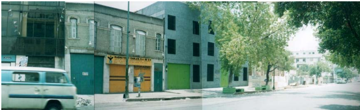
VISTA SUR CALLE MORELOS
