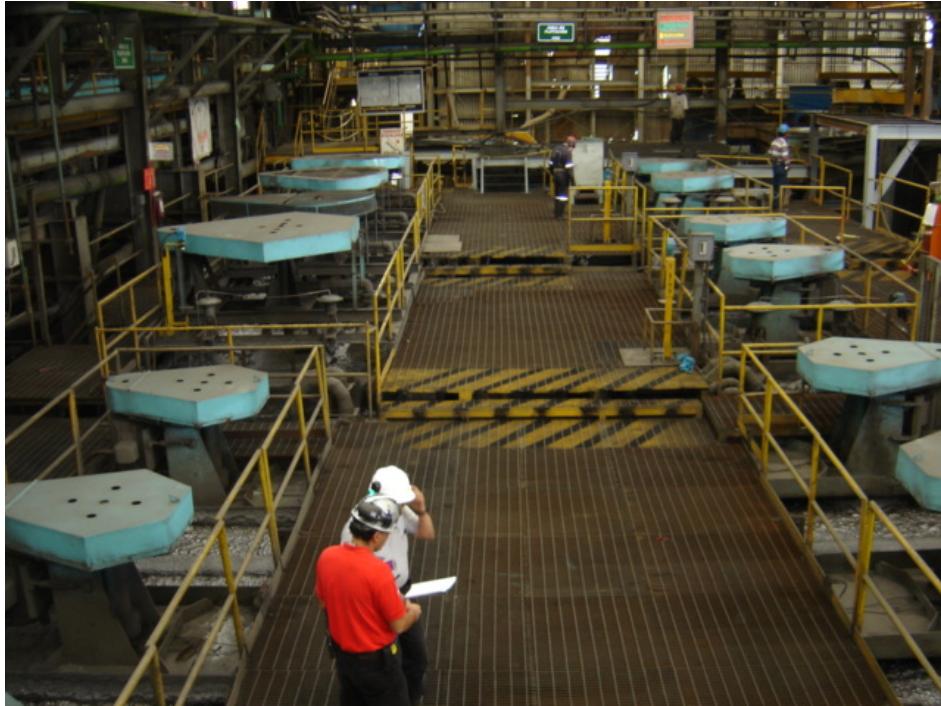
Foto 21: Circuito flotación zinc
