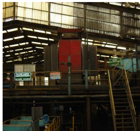
Foto 27: Filtro prensa zinc
