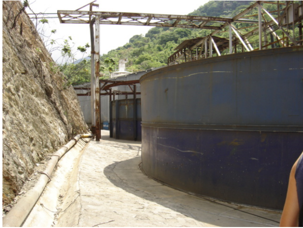
Foto 23: Espesadores de plomo y zinc
