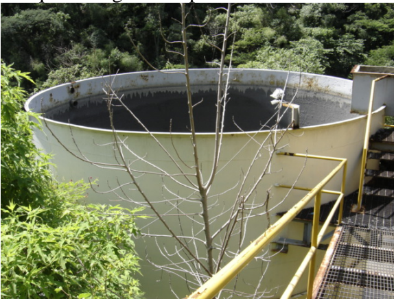
Foto 33: Tanque de agua de reproceso (PJMA5)
