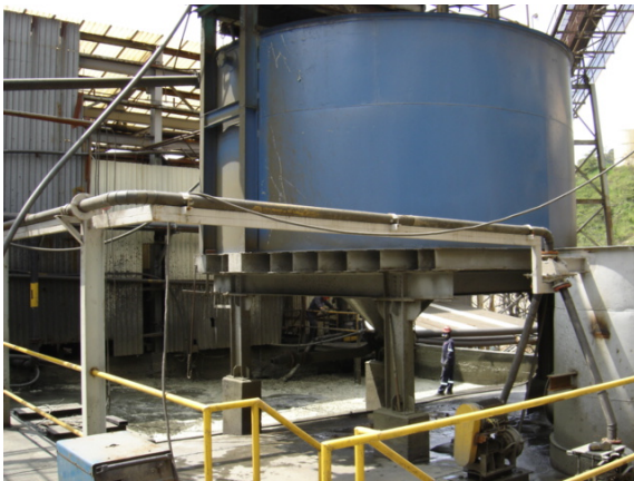
Foto 24: Espesador de cobre (fuera de servicio)
