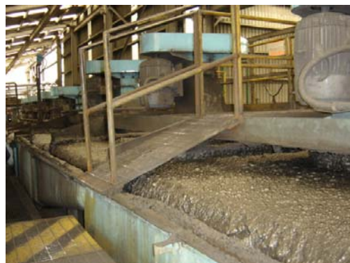
Foto 16: Circuito de flotación plomo cobre
