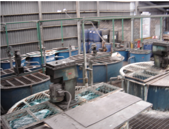
Foto 10: Área de acondicionamiento
