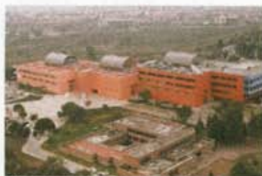
Conjunto antes de adaptación
