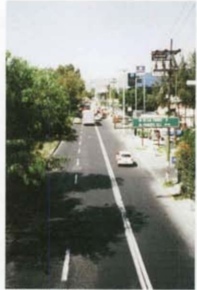
Cableado eléctrico sobre el Eje Central Lázaro Cárdenas.
