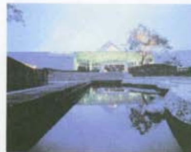
Fachada y patio de acceso principal
