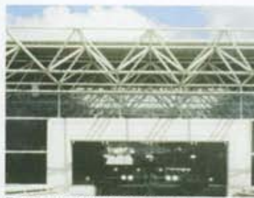
Fachada y acceso principal
