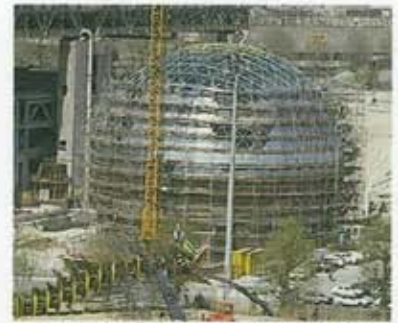
Montaje de estructura de La Géode, Paris.
