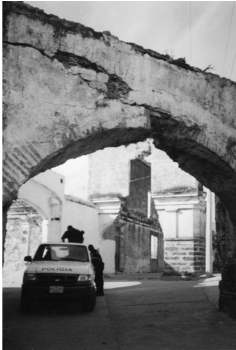
Uno de los tres arcos de medio punto existente en el acueducto
