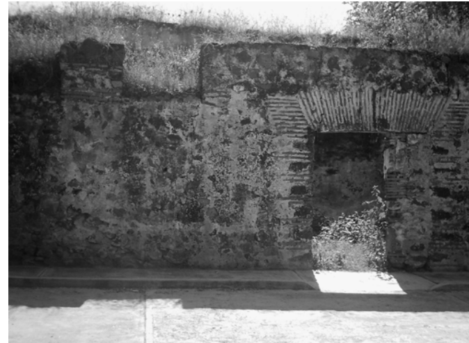
Muro existente con un vano
