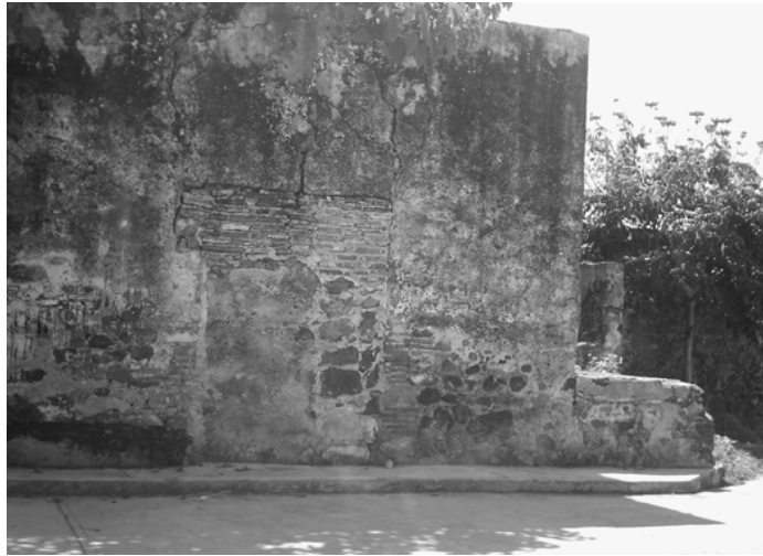
Muros a base de piedra y ladrillo
