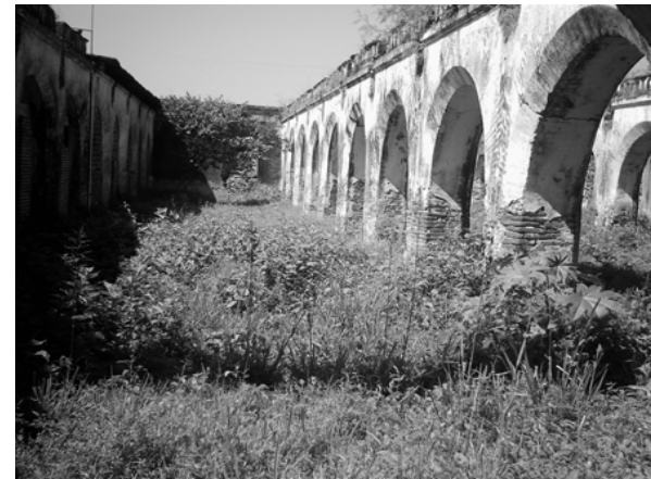
Arcadas existentes en el interior del inmueble
