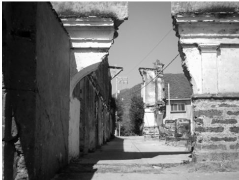
Muro con vestigio de arco rebajado
