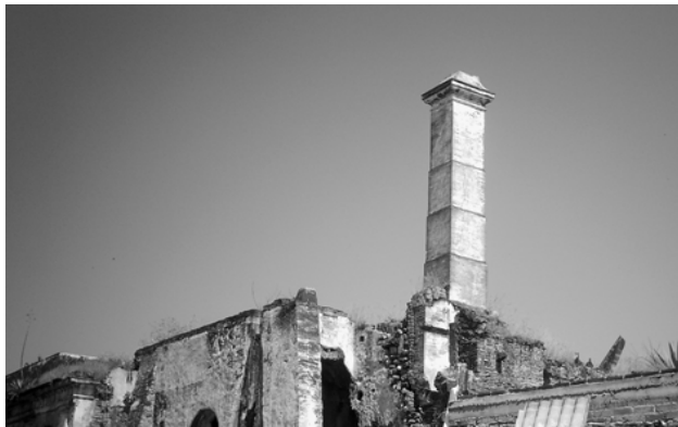
En la parte inferior se observa el carcamo cerca del chacuaco
