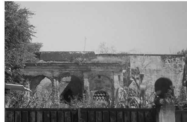
Arcos de medio puntos existentes
