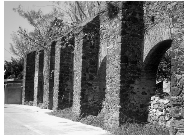
Muros de mampostería y ladrillo
