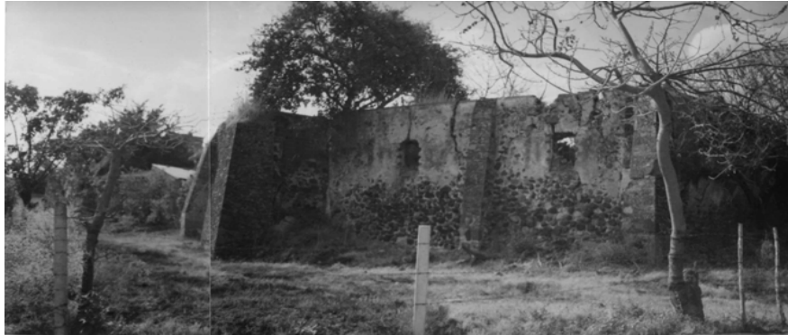
Muros de mampostería sin aplanar
