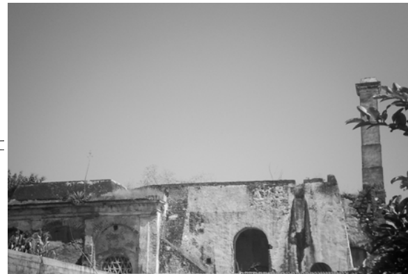
Vista lateral del carcamo
