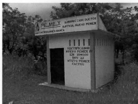
Figura 4.4. Rectificador de corriente impresa en el derecho de vía del poliducto de 12" D.N. Minatitlán-Villahermosa, 2005.
