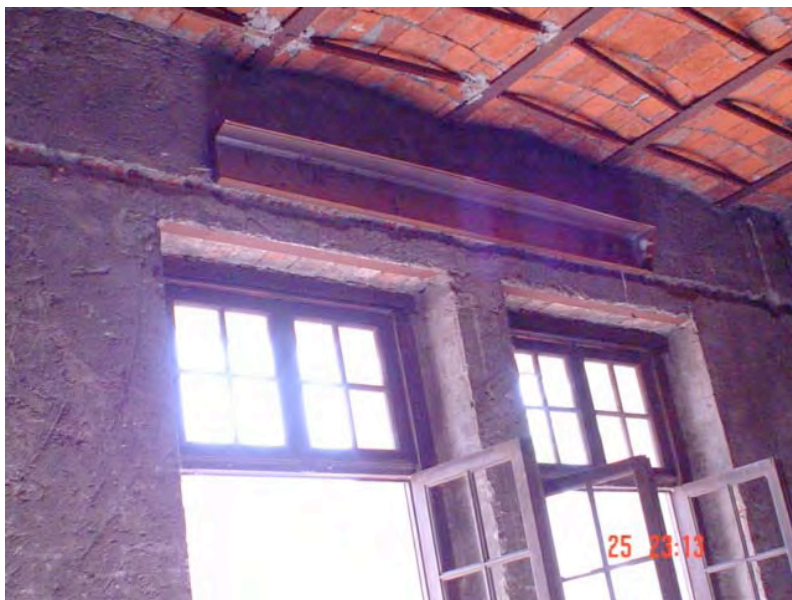
Fotografía 26: Detalle de los cerramientos de acero y de la manguetería de madera, así como del sistema estructural utilizado en las losas. Considerar que, además de las viguetas I de acero, la losa está reforzada mediante soleras de acero soldadas que están soldadas a las viguetas a todo lo largo de las mismas. Fotografía tomada in situ año 2004.
