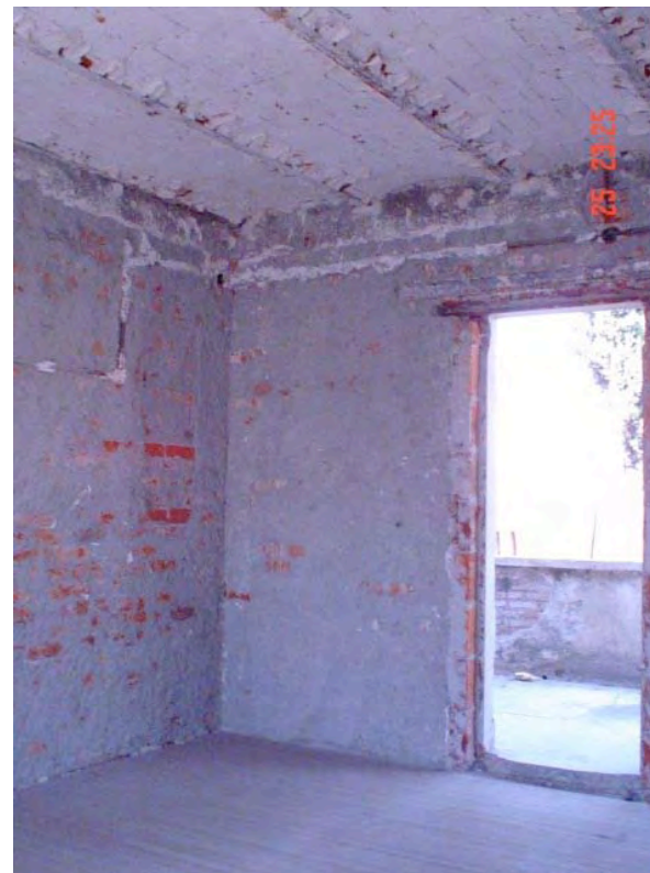
Fotografía 66: Habitación al oriente en primer piso. Nótese la falta de recubrimientos en los muros, falta de puerta, plafón y cornisas además de las instalaciones agregadas posteriormente. Fotografía tomada in situ año 2004.
