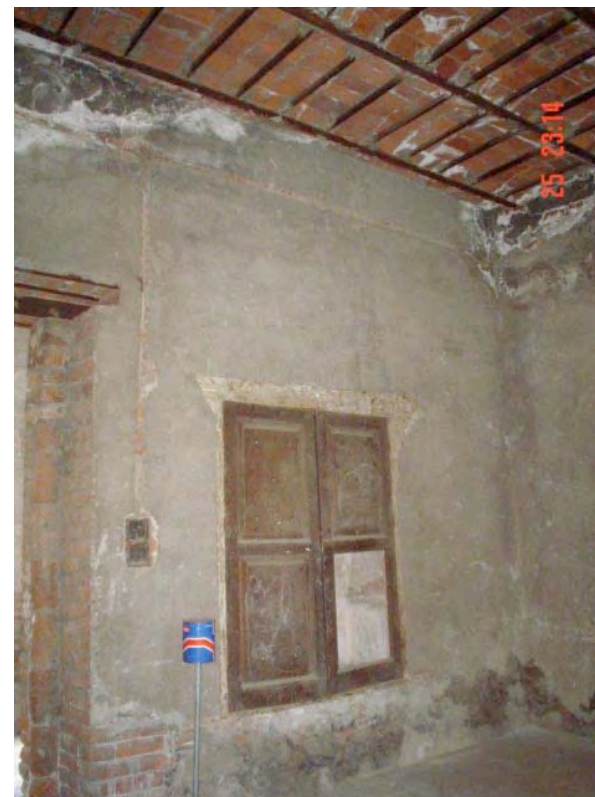
Fotografía 29: Vista de una de las habitaciones del lado noreste. Tomar en cuenta la ventana de madera y el cerramiento de la misma así como el material constructivo de los muros elaborados con tabique y tepetate y recubiertos con aplanado cal-arena, además de los deterioros provocados de las humedades y la falta de recubrimiento en algunas áreas. Fotografía tomada in situ año 2004.
