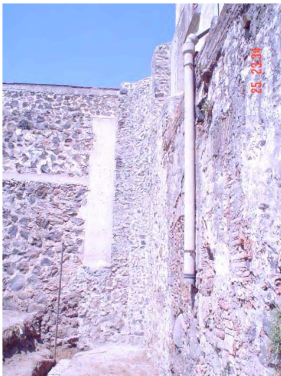
Fotografía 12: Detalle de los sistemas constructivos en parte de la fachada norte; gran parte de los muros en planta baja fueron elaborados con mampostería y tabique con mortero cal-arena. Podemos deducir que el recubrimiento era el mismo que el de la fachada oeste por el quiebre que éste hace al llegar a la fachada norte aunque no existen documentos que lo refieran. Fotografía tomada in situ año 2004.
