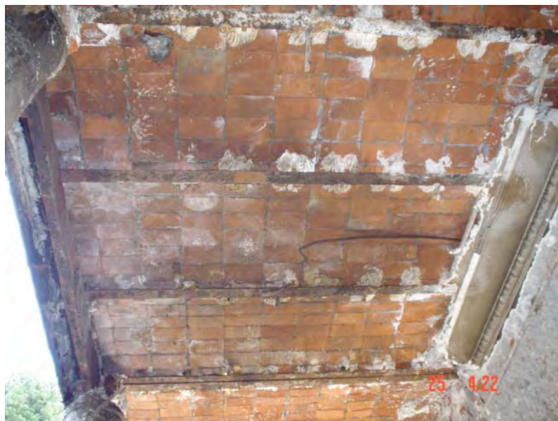
Fotografía 18: Detalle del plafond del pasillo en planta baja, donde puede observarse el sistema constructivo a base de viguetas I de acero apoyadas sobre vigas PTR de acero con semicaños de tabique de barro cocido. Fotografía tomada in situ año 2004.
