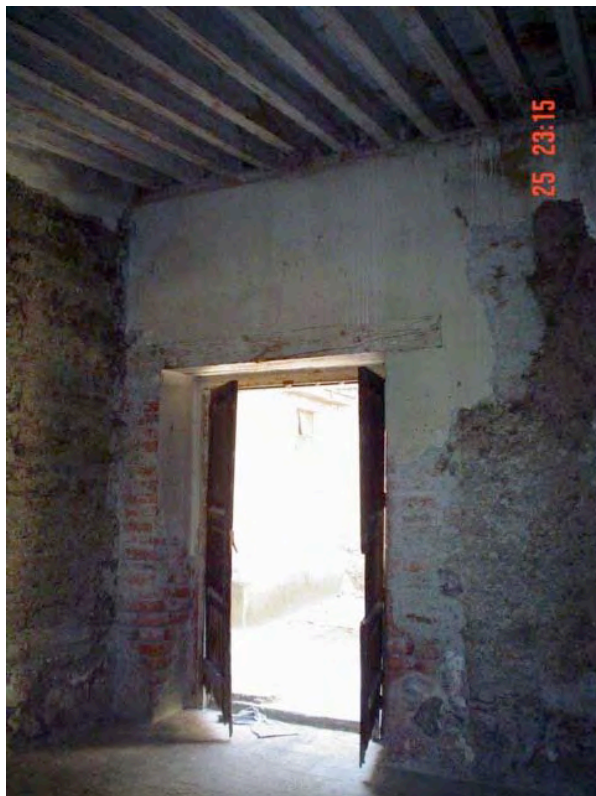
Fotografía 30: Detalle de la puerta de acceso a una de las habitaciones del lado noreste. Debe considerarse que existe gran mezcal de materiales como tepetate, piedra braza y tabique. La vigería es de madera al igual que los cerramientos en puertas y ventanas. Fotografía tomada in situ año 2004.
