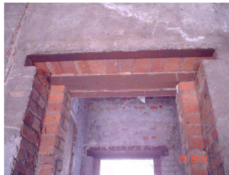
Fotografía 27: Detalle del cerramiento de una de las puertas que comunica una de las habitaciones con uno de los pasillos. Considerar que se encuentra reforzado por un PTR de acero sobrepuesto en los tabiques que conforman el cerramiento. Fotografía tomada in situ año 2004.
