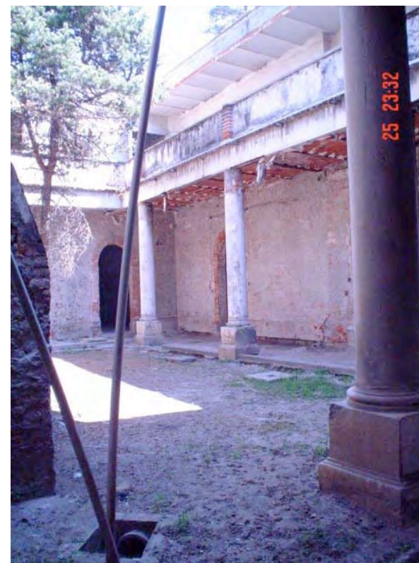
Fotografía 19: Vista general del patio en planta baja. Obsérvense las columnas que sostiene n la losa que cubre el pasillo que rodea el patio hechas de tabique de barro cocido, aplanado cal arena y acabado final de resina con pintura a la cal. Fotografía tomada in situ año 2004.
