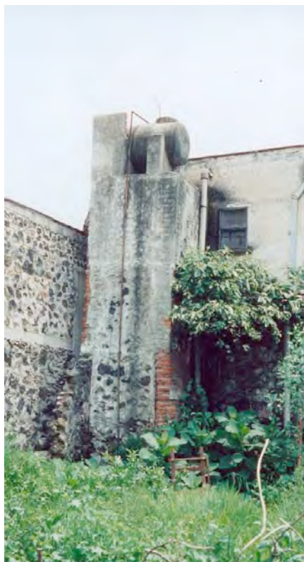
Fotografía 16: Detalle de la torre (agregado posterior) que se encontraba en la fachada norte y en el que se alojaban las instalaciones de gas y de agua en épocas recientes. Fotografía tomada in situ año 2000.
