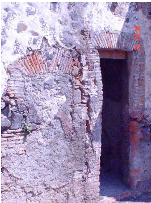
Fotografía 14: Detalle de los arcos escarzanos que enmarcan tanto el acceso lateral norte como los vanos tapiados en planta baja. Obsérvense los diferentes materiales con los que fue elaborado el muro predominando la mampostería. Fotografía toma in situ 2004.
