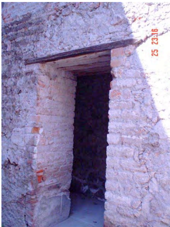
Fotografía 35: Detalle del vano que comunica uno de los pasillos (generado posteriormente) con el patio secundario. Obsérvese el cerramiento de madera y las jambas de tabique contrastando con el resto de los materiales que conforman el muro. Fotografía tomada in situ año 2004.
