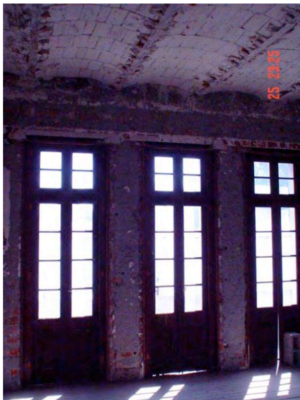
Fotografía 63: Ventanas de la habitación principal al oriente en el primer piso. Deformación de la madera en las ventanas y en las tiras de la duela. Fotografía tomada in situ año 2004.
