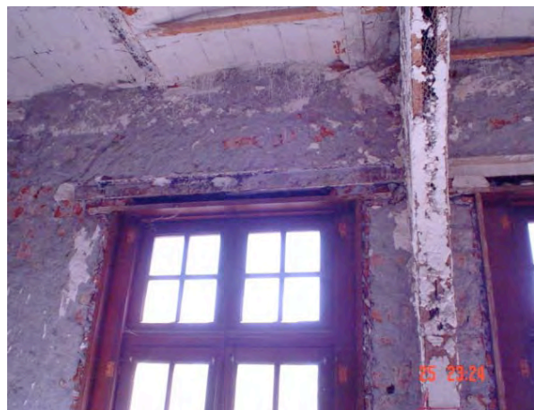
Fotografía 61: Habitaciones al oriente del primer piso. Se aprecia la existencia de muros falsos hechos de tela de gallinero con tambor de madera y recubiertos de yeso. Fotografía tomada in situ año 2004.
