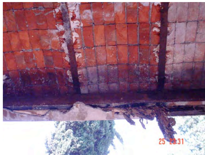
Fotografía 23: Detalle de la viga PTR en la que se apoyan las viguetas I de acero que conforman el sistema constructivo de la propia losa. Fotografía tomada in situ año 2004.
