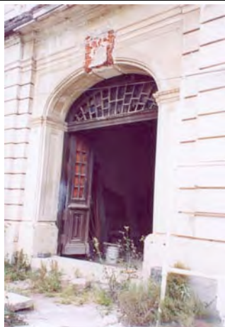
Fotografía 3: Detalle del acceso al inmueble. Considerar el material constructivo de esa área: Tabique como base del muro, aplanado cal arena como acabado inicial y acabado final a base de resina con pintura a la cal. Fotografía tomada in situ año 2000.
