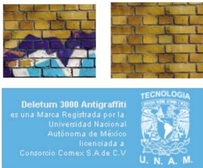
Fig. IV.7. Antes y después con la pintura antigraffiti desarrollada y registrada por la UNAM.
