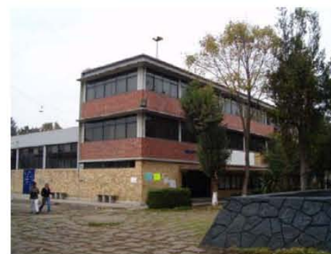
Fachada de la actual Biblioteca de la E.N.P No5 2
