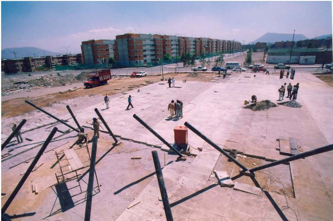
Construcción inicial FARO de Oriente
