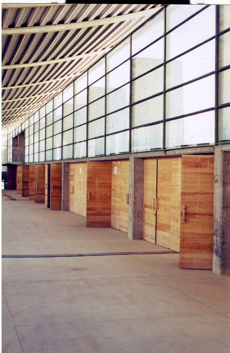
Salones para talleres, primer piso
