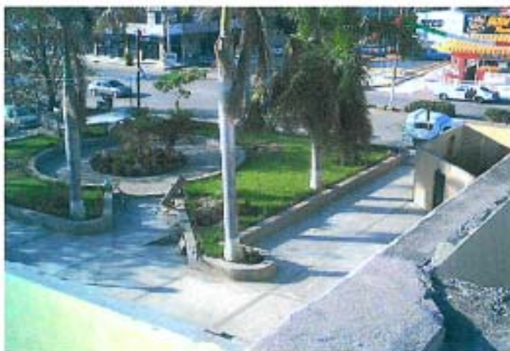
VISTA PANORÁMICA DE LA PLAZA PRINCIPAL DEL HOSPITAL GENERAL DE SUBZONA 42 CAMAS, UBICADA EN LA ESQUINA DE BLVD. ROSALES Y AVE. EMILIANO ZAPATA.
