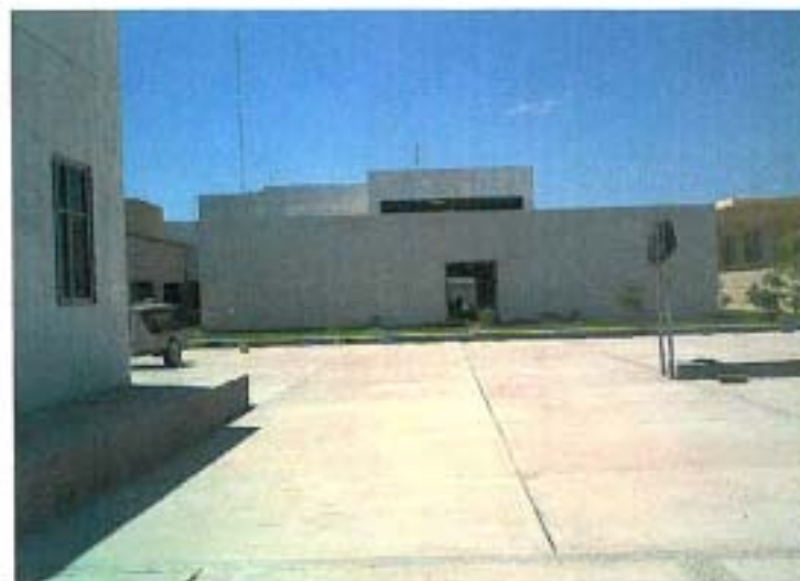
VISTA DE FACHADA SUR DEL CUERPO "B" HOSPITALIZACIÓN, APRECIANDOSE FONDEO Y EN LOSA DE AZOTEA EL CUERPO "C" ENSEÑANZA.
