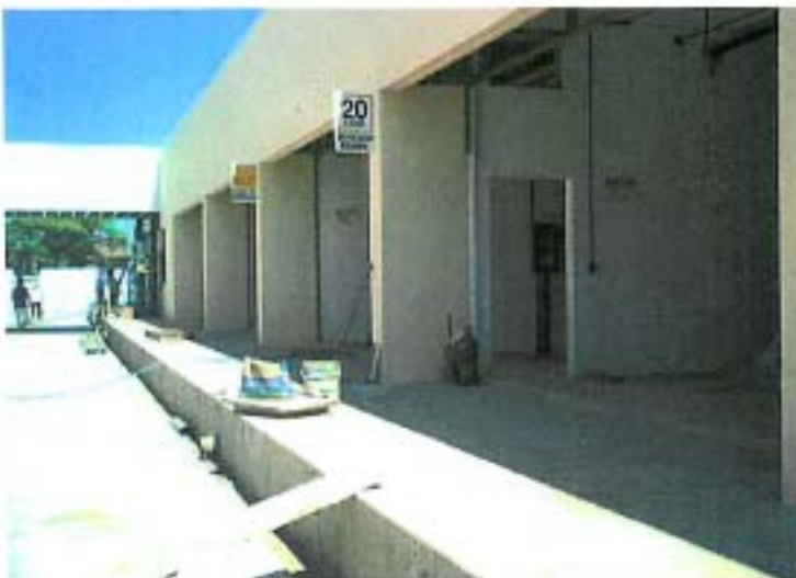
VISTA DE FACHADA NORTE DEL CUERPO "E", APRECIANDOSE PINTURA EN MUROS Y LETREROS INDICATIVOS, EN ACCESO VEHICULAR DEL HOSPITAL
