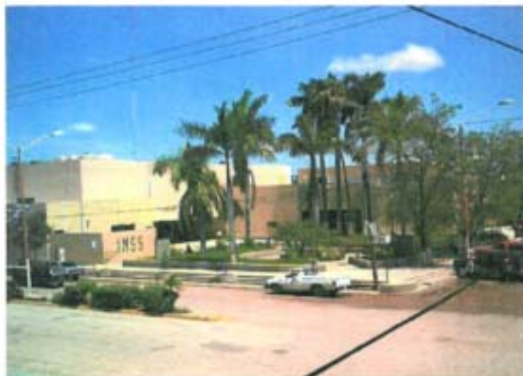
VISTA PANORÁMICA DE LA PLAZA DE ACCESO PRINCIPAL A LA UNIDAD DE MEDICINA FAMILIAR Y EL HOSPITAL GENERAL DE SUBZONA DE GUAMÚCHIL SINALOA.
