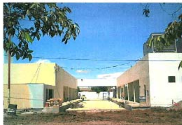
ACCESO PRINCIPAL A ESTACIONAMIENTO SOBRE LA AVENIDA EMILIANO ZAPATA, DESTACANDO EN EL LADO DERECHO CUERPO "E" CASA DE MAQUINAS Y A LA IZQUIERDA CUERPO "D" SERVICIOS GENERALES.
