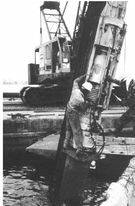
Fig. 5. Hincado de pilote con martillo diesel.
