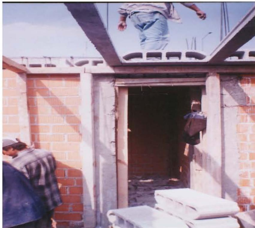
FIG IX.2 COLOCACION DE BOVEDILLAS , LAS DIMENSIONES DE LAS BOVEDILLAS ESTAN DETERMINADAS POR LOS EJES DE LAS VIGUETAS.
