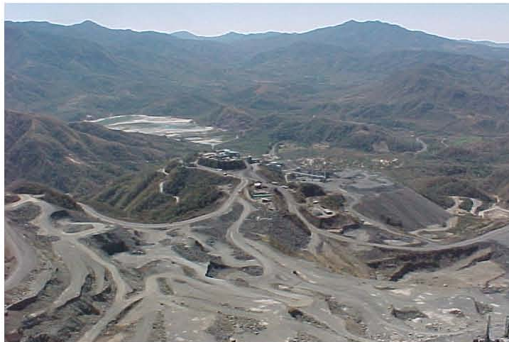
Figura 6. Caminos de acceso en la mina INSTALACIONES CMBJPC
