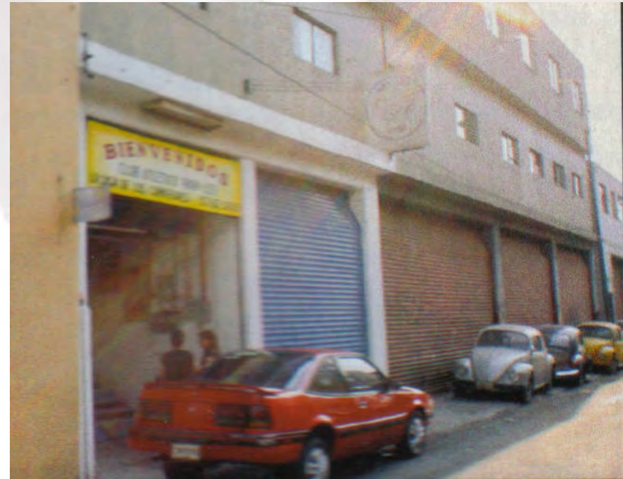
Imagen 16. Vista del acceso al Club Atlético Ham Lee, donde se puede apreciar la falta de estacionamiento.
