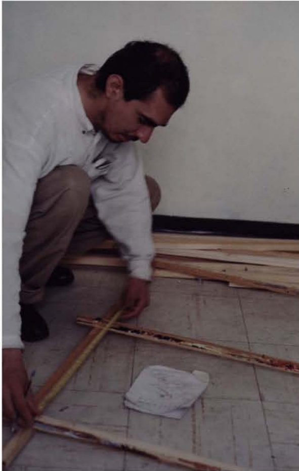
La elaboración de la estructura de soporte
