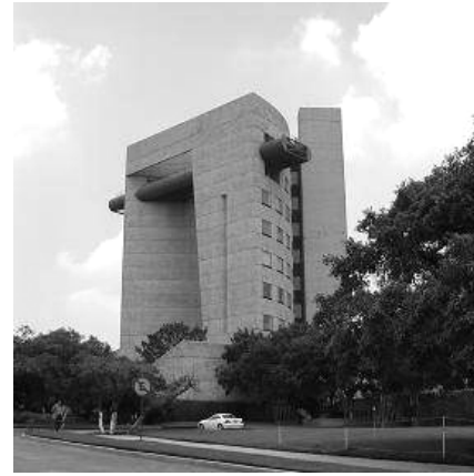
EDIF.FONDO CULT. ECONÓMICA Carretera Picacho-Ajusco. D.F.
