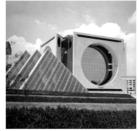
EDIFICIO CALAK-MUL. Santa Fe. D.F.
