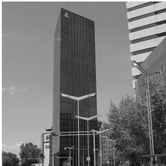
EDIFICIO LOTERÍA NACIONAL. CENTRO D.F. ARQ. RAMÓN TORRES MARTÍNEZ. TALLER CARLOS LAZO.
