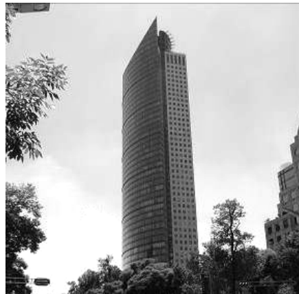
TORRE MAYOR. Paseo de la Reforma 505. D.F.
