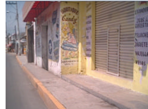
Imagen 5.1.1. Foto del deterioro de la imagen urbana de Tetelco.
