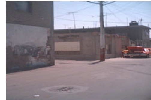
Imagen 5.1.1. Foto del deterioro de la imagen urbana de Tetelco.
