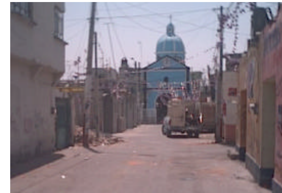
Imagen 6.6.1. Diagnostico de vivienda.
