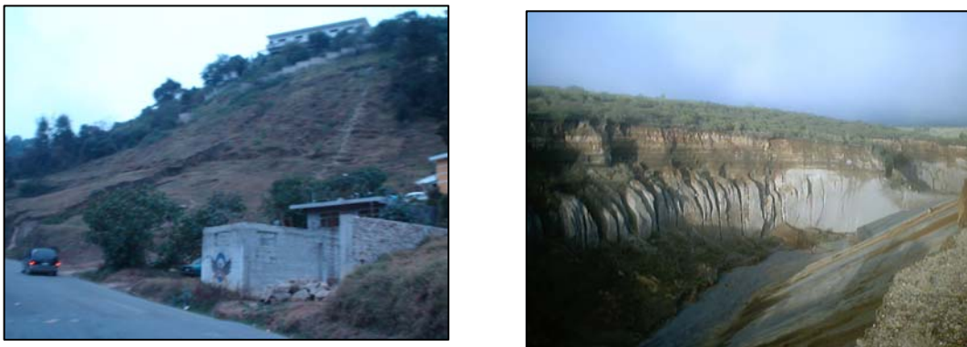
Fig. 1.9 Factores internos y externos de inestabilidad. Los cortes artificiales, por ejemplo carreteras, pueden llegar a un factor externo de inestabilidad –imagen izquierda- (Libramiento en Zacapoaxtla; foto del autor); la litología es uno de los factores internos más importantes en la ocurrencia de procesos de remoción en masa – imagen derecha- (Sur de Tlatlauquitepec; foto del autor).
