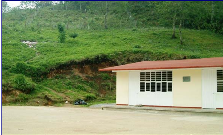
Figura 4.8 Ladera en análisis antes del impacto del huracán Stan.
