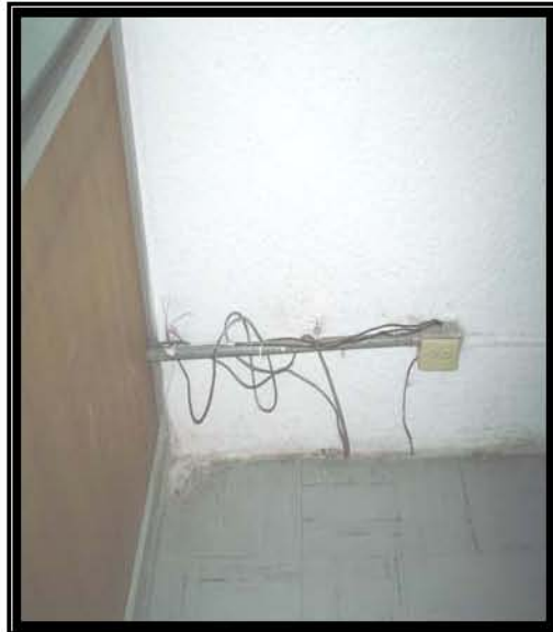
Fotografía 28 En esta fotografía se puede observar cable UTP CAT 5 enredado en una tubería de energía eléctrica así como parte de una extensión de energía eléctrica con las puntas sin aislar en la misma instalación Eléctrica, esto no solo va en contra de los estándares de comunicaciones sino de seguridad y protección civil
