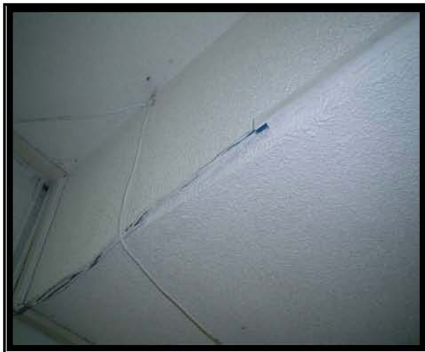
Fotografía 7 Cableado con canalización y engrapado con pintura blanca
