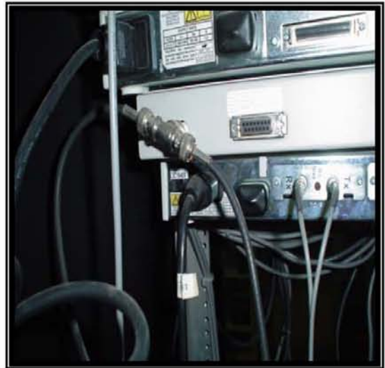
Fotografía 6 Muestra un par de fotografías con las tomas de energía eléctrica y como se puede observar van en contra del estándar de alimentación a equipos de comunicaciones
