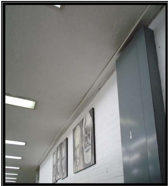
Fotografía 33 Muestra un par de fotografías con canaleta tipo U de 5 cm. y en la otra fotografía se observa una parte canalizada y otra sin canaleta.
