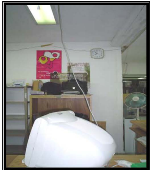
Fotografía 25 En esta fotografía se observa nuevamente el área de préstamos en cuanto al cableado esta pegado con cinta canela en la pared y se observa también un UTP CAT 5 colgando del plafón para alimentación de red a otra computadora.
