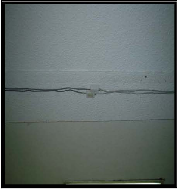
Fotografía 32 Muestra un par de fotografías con canalización y se puede observar un par de empalmes al UTP las trayectorias del cableado están engrapadas al plafón.
