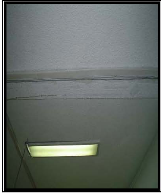
Fotografía 32 Muestra un par de fotografías con canalización y se puede observar un par de empalmes al UTP las trayectorias del cableado están engrapadas al plafón.
