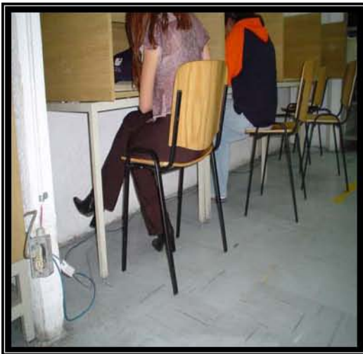
Fotografía 20 En esta fotografía se puede observar un nodo de red implementado en condiciones de premura y austeridad el cual traerá costos mayores ya que este material en poco tiempo no funcionará y se tendrá que gastar nuevamente en la implementación, se observan cables UTP CAT. 5E y UTP CAT. 5, enredado con una toma de energía eléctrica sin sujetar solamente esta fijado por los UTP's que están sujetos en la extensión de energía eléctrica y su trayectoria como se observa va en el piso entre los pies de los usuarios.
