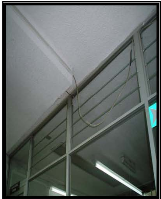
Fotografía 33 Muestra un par de fotografías con canaleta tipo U de 5 cm. y en la otra fotografía se observa una parte canalizada y otra sin canaleta.
