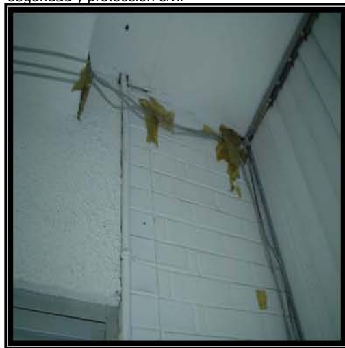
Fotografía 28 En esta fotografía se puede observar cable UTP CAT 5 enredado en una tubería de energía eléctrica así como parte de una extensión de energía eléctrica con las puntas sin aislar en la misma instalación Eléctrica, esto no solo va en contra de los estándares de comunicaciones sino de seguridad y protección civil
