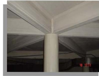
La separación de los cuerpos para su trabajo estructural independiente, juntas constructivas visibles, pero desapercibidas.
