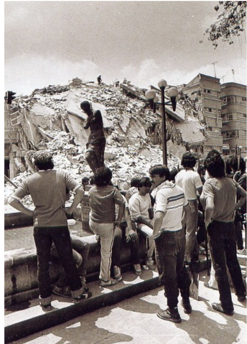
Edificio Colapsado por el terremoto de 1985 en la Av. Álvaro Obregón e Insurgentes.
