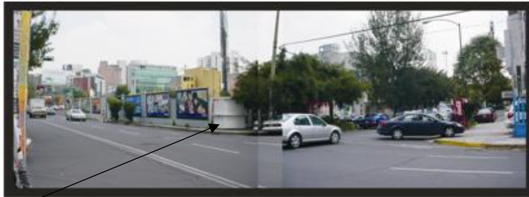
Vista al terreno de la Calle Zacatecas.
