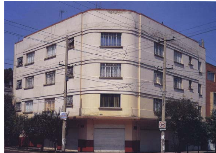
Edificio estilo funcionalista de extrema sencillez y la ausencia total de ornamentación. Uno de los últimos que se construyó en la Roma.
