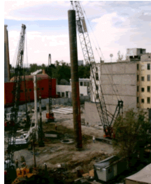
Pilas de cimentación.
