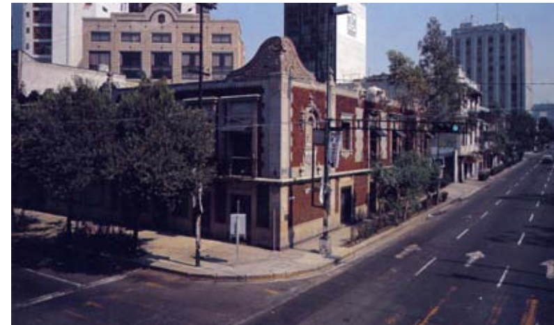
Casas estilo neocolonial, sobresale por el recubrimiento de tezontle y las decoraciones de azulejo de su fachada. El remate de su esquina, con un relieve de espeso follaje contenido por dos grandes roleos.
