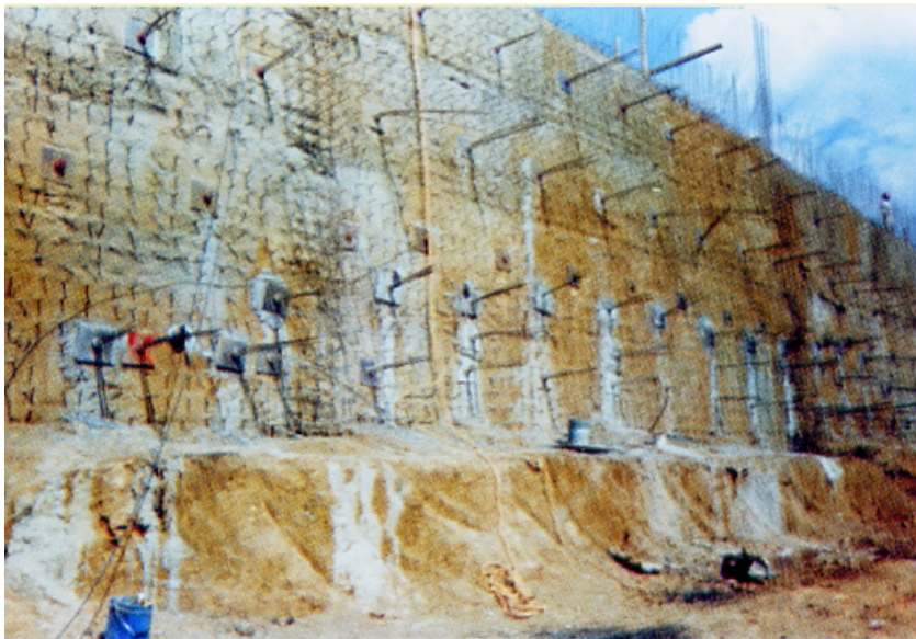
Muro de contención.
