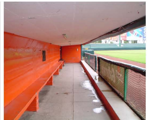
Bancas, el acabado predominante en el estadio es un acabado fino de cemento-arena y pintura
