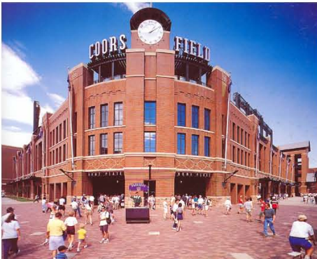
Campos Coors, Colorado Estados Unidos, Vista de la entrada que da al Centro Urbano
