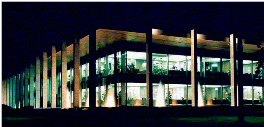
Vista de Conjunto del Edificio Central del Comité Administrador del Programa Federal de Escuelas (CAPFCE), ubicado en Vito Alessio Robles # 380., Col. Florida, Delegación Álvaro Obregón, Ciudad de México. (El Monte Olimpo)
