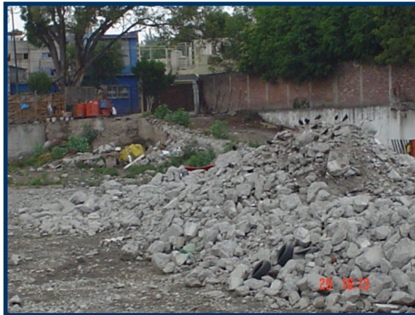
VISTA DEL TERRENO LADO PONIENTE CALLE PALESTINA
