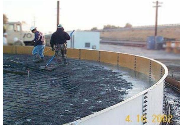
**Figura 3 Construcción de un tanque atmosférico**
