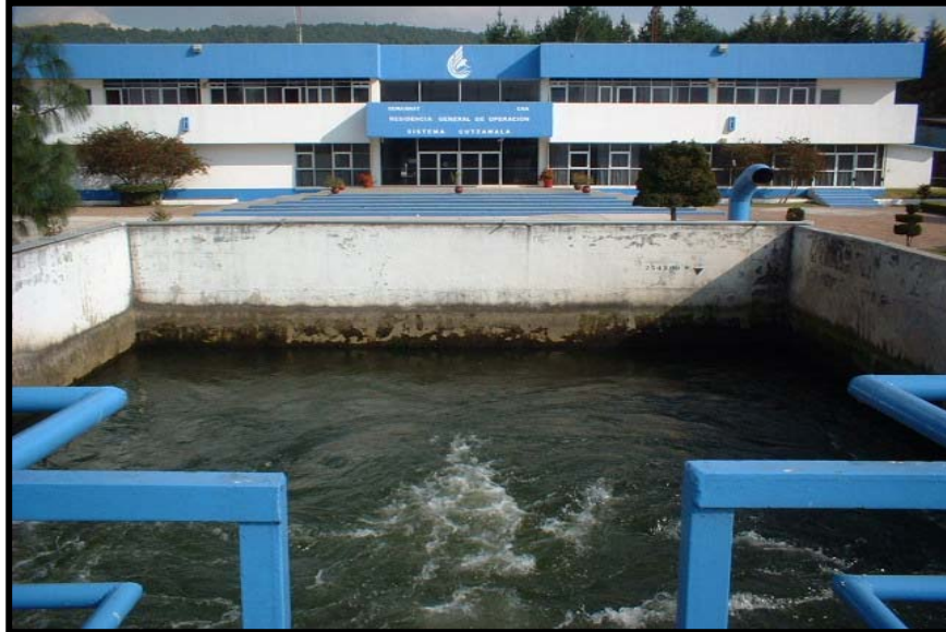
Figura A Tanque de recolección del influente de la planta potabilizadora de “Los Berros”.
