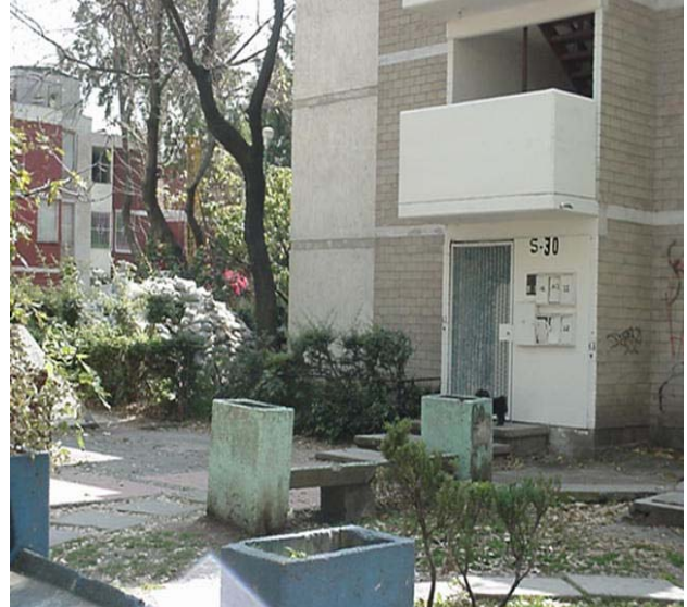
Foto 2. Fachada principal del edificio S-30
