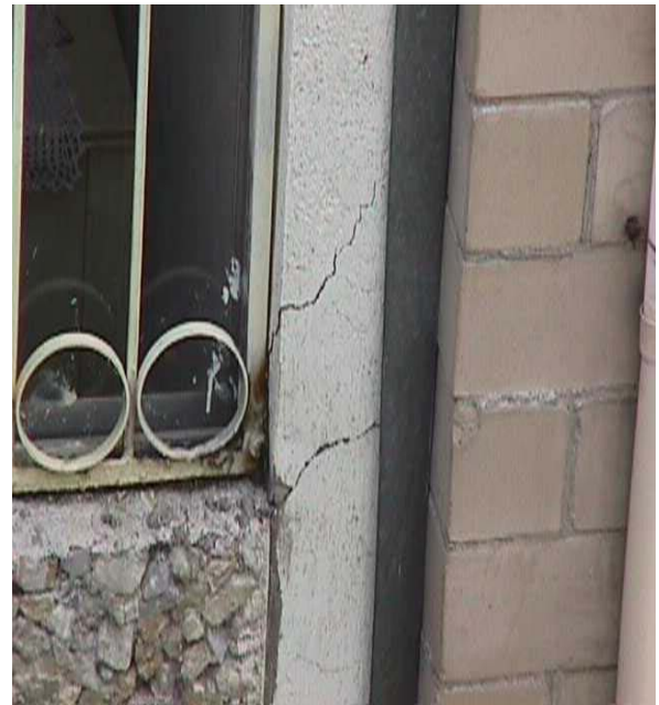
Acercamiento al daño que se produce en el muro de borde, que carece de rigidez al no tener una mocheta. En el proyecto arquitectónico la ventana estaba proyectada en el lado opuesto.
