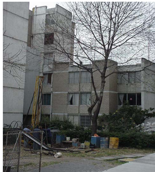
Foto 4. Sondeo en zona oriente del edificio S-30
