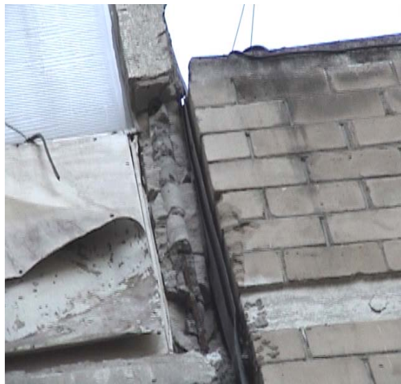
A la derecha de la imagen se aprecia un acercamiento del pretil de azotea del edificio S-30, que deberá ser reducido en su altura para permitir que las losas sean las que reciban la compresión entre ambos edificios.
