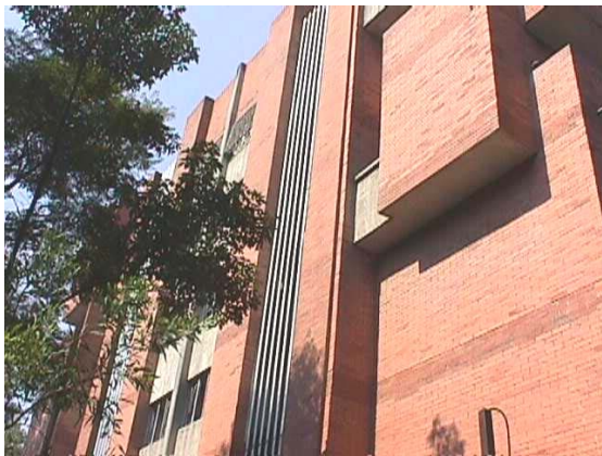
Vista de la fachada Sur
