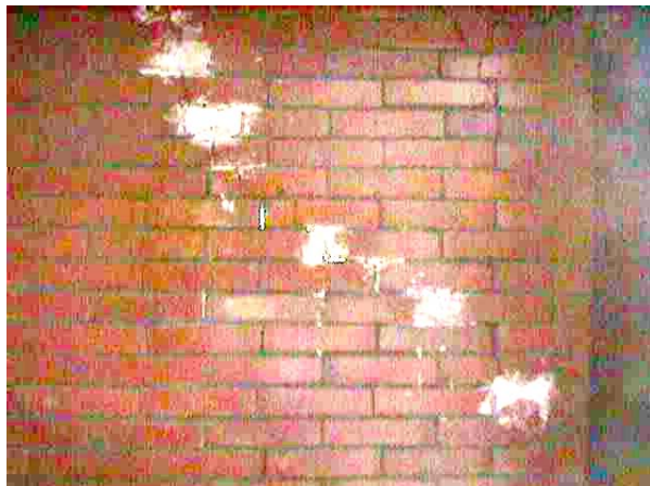
Grieta en el muro de una recamara dentro del Departamento 401
