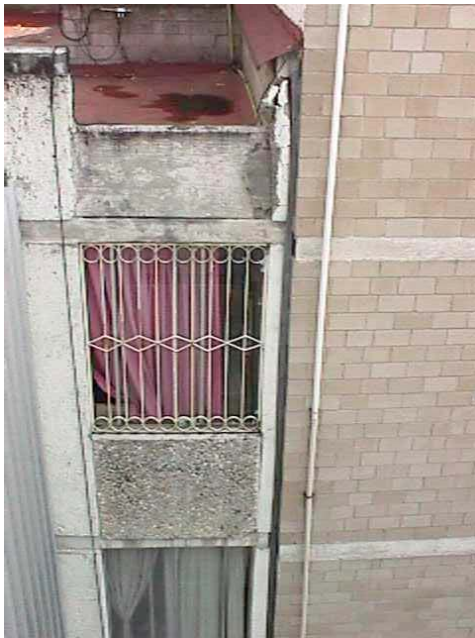
Vista del lado Oeste del contacto entre el edificio S-30 y S-32, donde los daños son menores pero también se presentan fisuras, los muros junto a las ventanas no cuentan con rigidez suficiente.
