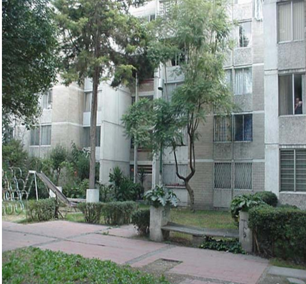
Foto 1. Fachada de los edificios
