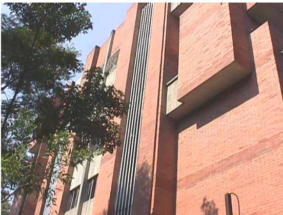
Vista de la fachada Sur
