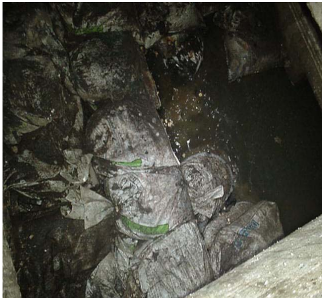
Foto 7. Celda de cimentación con lastre
