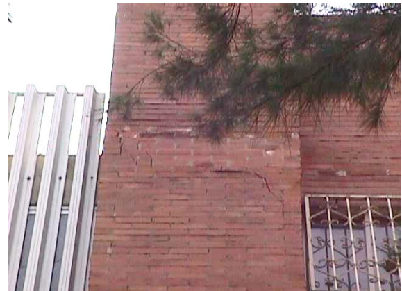
Vista exterior de los niveles superiores de la fachada Norte
