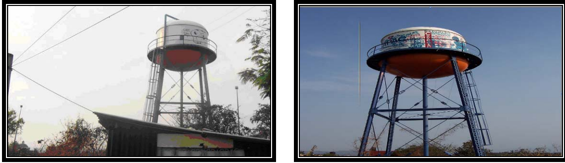
Foto 1 y 2.- Tanque de abastecimiento.
