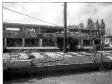
Fachada oriente (principal).
