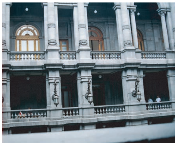
Dependiente del Instituto Nacional de Bellas Artes (INBA), el Museo Nacional de Arte (MUNAL) abrió sus puertas en 1982, en el Antiguo Palacio de Comunicaciones, obra de principios de siglo XX encomendada por el gobierno porfirista al arquitecto italiano Silvio Contri.
