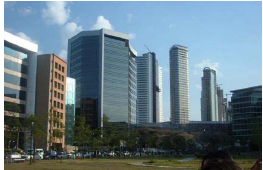
ZONA DE EDIFICIOS CRUZ MANCA
