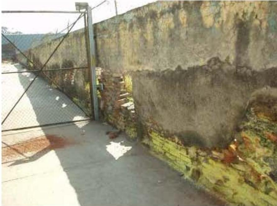
*Fig. 5. Ejemplo de la filtración de residuos del contenedor hacia los exteriores de los antiguos terrenos de Cromatos de México (9/2005). Nótese la reja que delimita el predio.*
