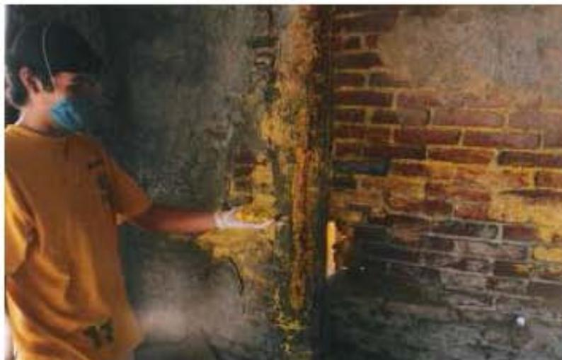
*Figura 14. Muestra de la cantidad de sales que se precipitan en los muros de Cromatos de México.*
