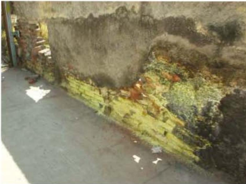
*Figura 9. Residuos crómicos en un muro exterior de Cromatos de México.*
