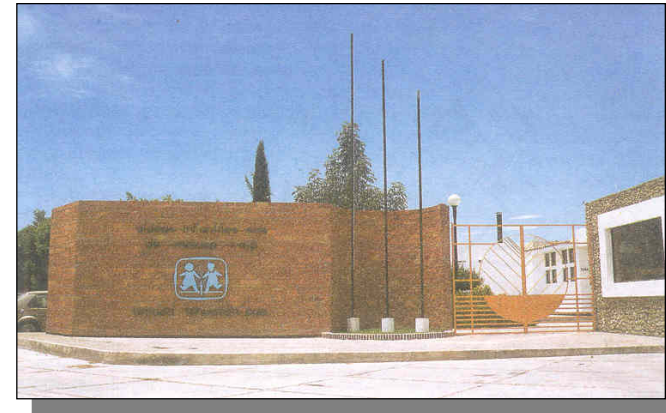
Figura 2.1 Fachada principal Aldea SOS, Tehuacan, Puebla.
