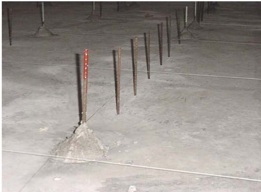
Figura 2.6.3 Nivelación de las varillas para configurar la batimetría.
