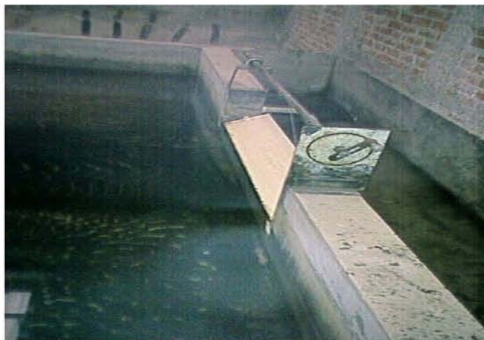
Figura 2.6.14 Compuerta abatible aguas abajo de la estructura.
