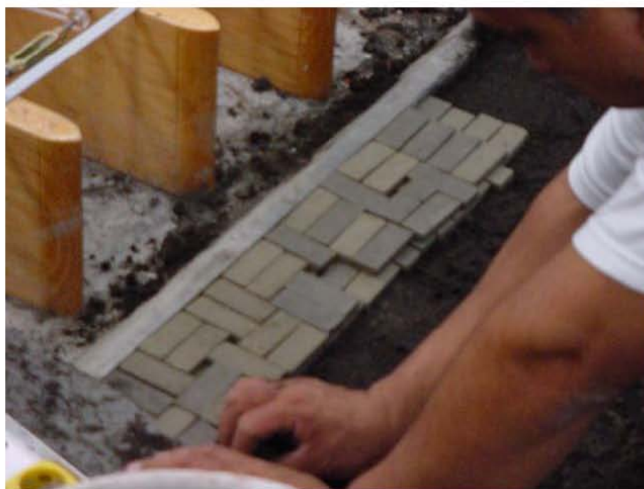
Fig. 3.1.6 Colocación de la protección aguas abajo de la zona de descarga.
