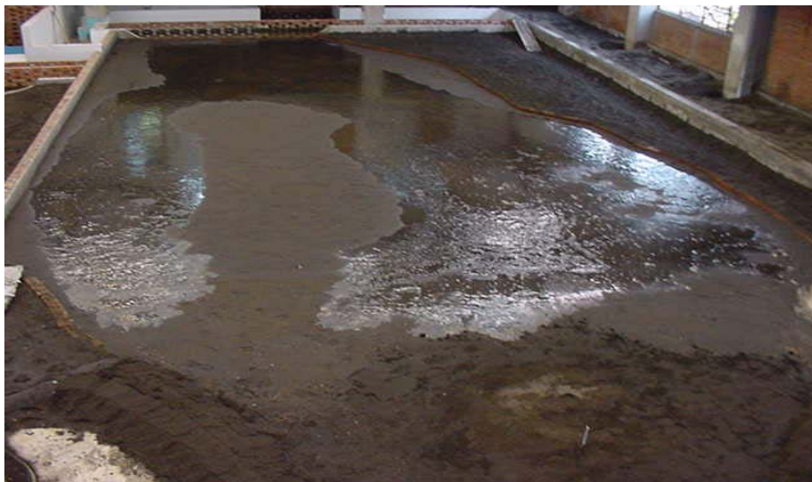
Figura 2.6.17 Panorámica del cauce de la estructura, hacia arriba.
