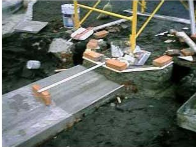
Figura 2.6.5 Vista de la base de la estructura. (Se aprecia el tanque amortiguador y el umbral del mismo).
