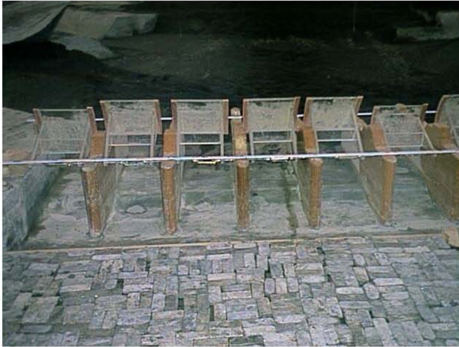
Fig. 3.1.7 Tapete de protección del cauce aguas abajo de la estructura de control.
