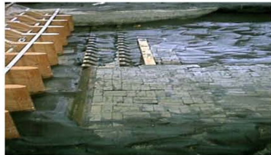
Figuras 2.6.9 y 2.6.10 Estructura disipadora con dientes y estructura disipadora con en bloques de concreto respectivamente.
