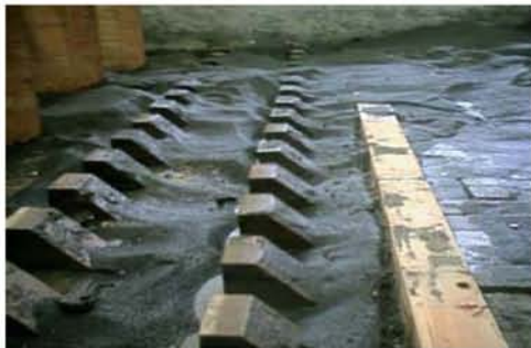
Figuras 2.6.9 y 2.6.10 Estructura disipadora con dientes y estructura disipadora con en bloques de concreto respectivamente.
