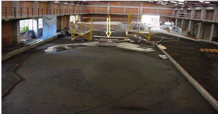
Figura 2.6.16 Panorámica del cauce aguas arriba de la estructura.
