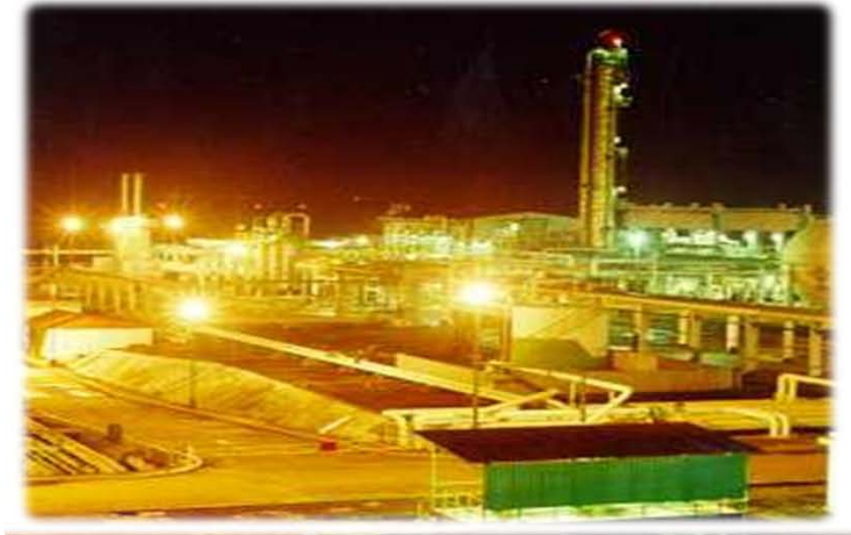
Complejo Procesador de Gas Burgos,
