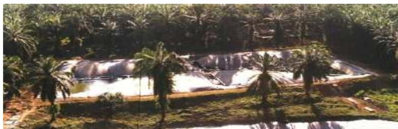
Figura 12. Planta de biogás tipo globo en Alemania
