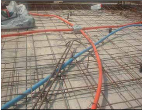
Ductería y accesorios para instalación de energía eléctrica en losas, La supervisión debe cuidar que las mangueras no se obturen o rompan.
