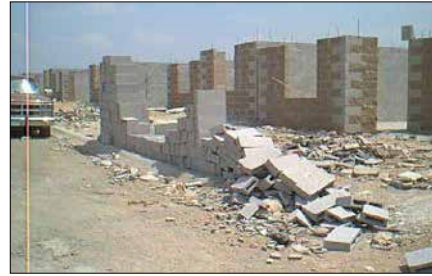
Edificación de vivienda de interés social a base de muros de block hueco, que es uno de los materiales de mayor aceptación, tanto en zonas áridas como en las costeras del país.
