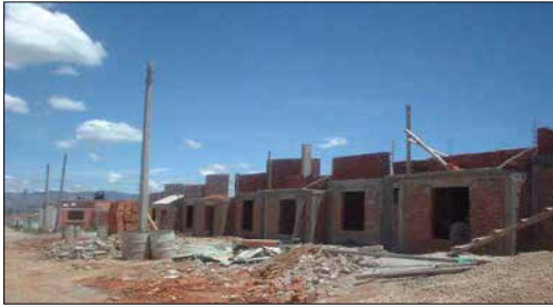
Vivienda de interés social resuelta con muros de tabique rojo, material de amplia demanda en el altiplano de la República Mexicana.
