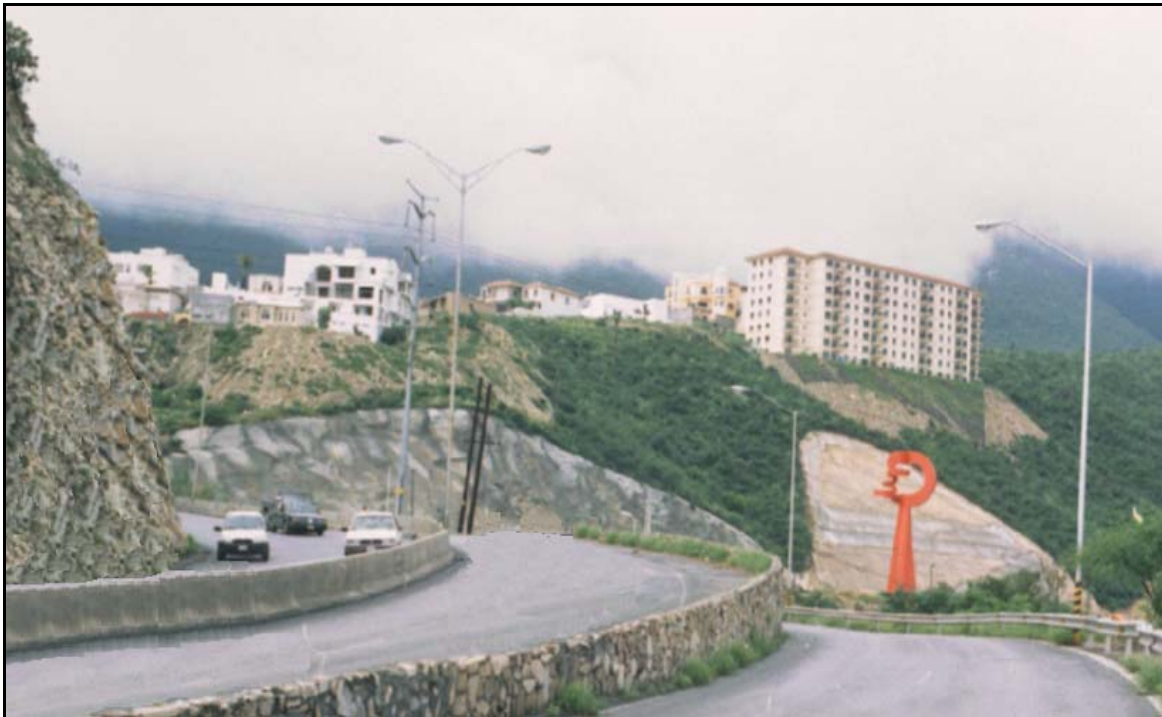
Fotografía IV.2.3.2. Estabilización con concreto lanzado.
