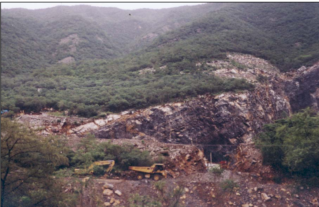
Fotografía IV.2.2. Maquinaria y zona de la excavación al pie del talud.
