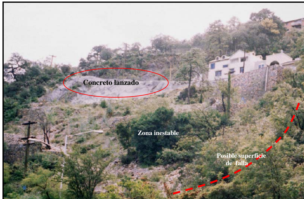
Fotografía IV.2.2.4. Concreto lanzado en la parte superior de la ladera y construcciones en la cima de esta.
