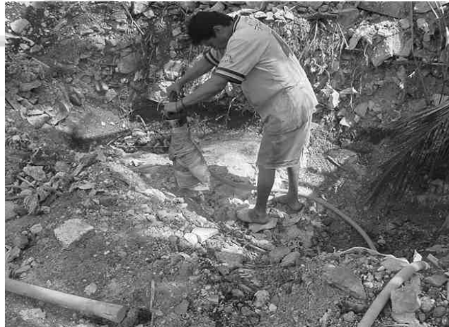
Detalle de la excavación en roca para la construcción de la fosa séptica con recursos del Crédito Hipotecario para ampliación de vivienda.
