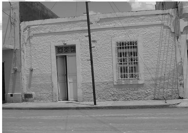
Fachada de un inmueble en el que se realizo ampliación dentro del mismo.
