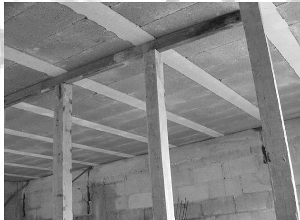
Colado de la losa de vigueta y bovedilla en la ampliación de un inmueble con recursos de Crédito Hipotecario.
