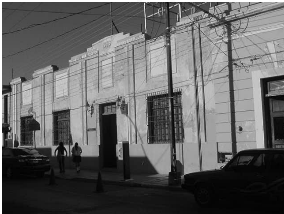
Fachada de Oficinas Generales del ISSTEY.
