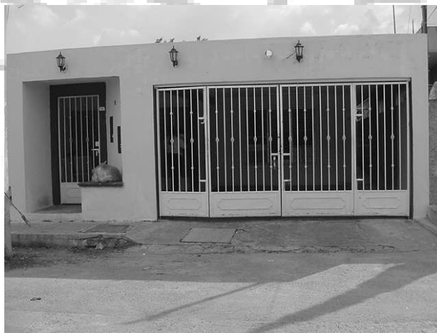
Vista exterior de una vivienda que se obtuvo con el Crédito Hipotecario compra de casa a terceros.
