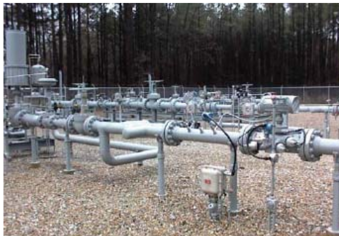
Fig. 5B: Arreglo en campo. Patín de Medición Ultrasónica.
