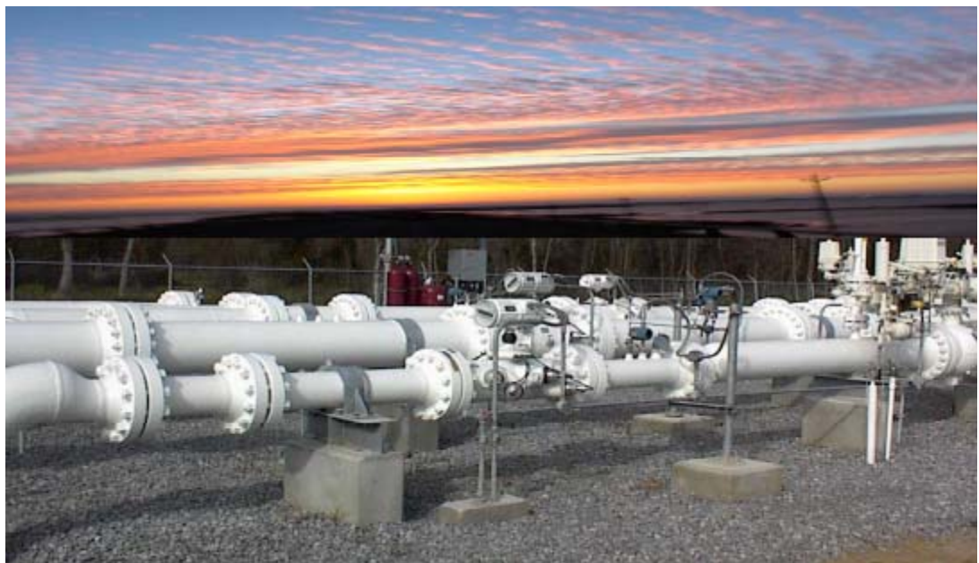
Fig. 4C: Configuración en línea. Sistema de Medición Ultrasónica de Flujo.
