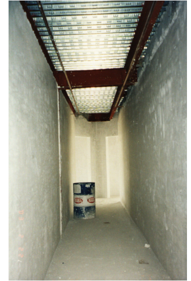
Fig 68 Losa soportada por estructura metálica y lamina roma Departamentos en la Col. Roma Azamar M. Aurora Constructora Yama (2003)
