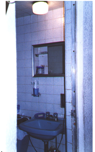
fig. 155 Aspecto de recubrimiento en baño
