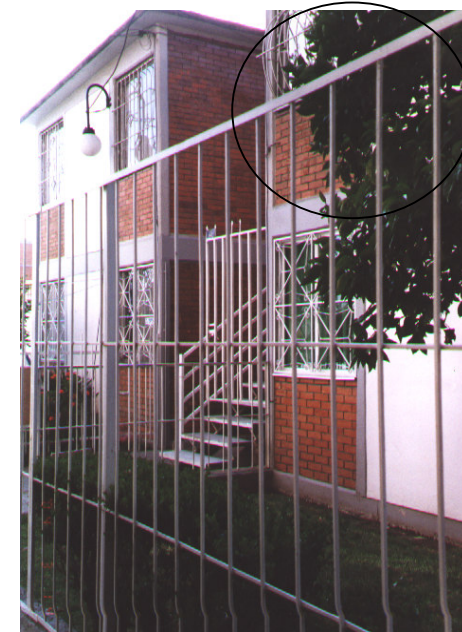
fig 127 Fachada del conjunto duplex
