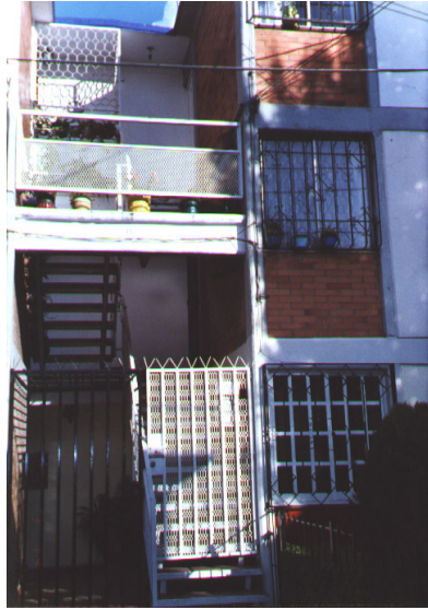
fig. 143 Fachada de conjunto triplex
