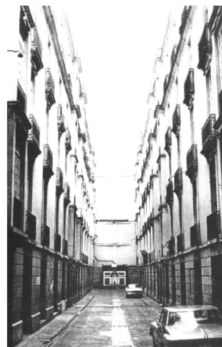
fig.8 Barros (1997) Edificio Vizcaya
