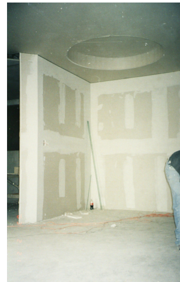
Fig 72 Diseño de cajillo en plafón de comedor Departamentos en la Col. Roma, Azamar M. Aurora Constructora Yama (2003)
