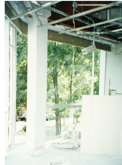
Fig. 63 Armado de bastidor para la colocación de plafón Departamentos en la Col. Roma, Azamar M. Aurora Constructora Yama (2003)
