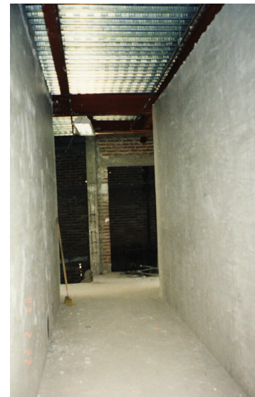
Fig. 69 Losa soportada por estructura metálica y lamina roma Departamentos en la Col. Roma, Azamar M. Aurora Constructora Yama (2003)
