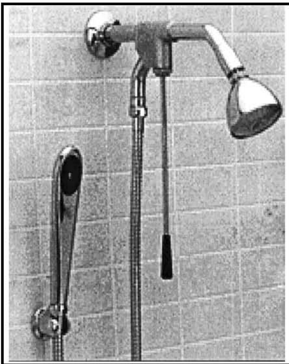
Fotografía 8. Regadera de teléfono.
